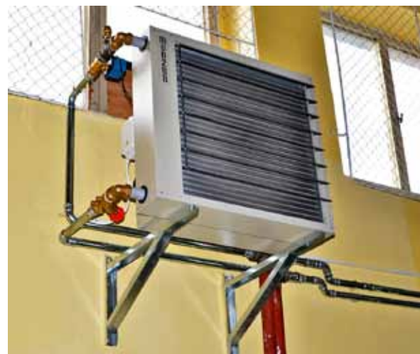
Rekonštrukcia kúrenia telocvične ZŠ
