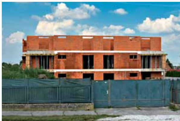
Výstavba posledného poschodia
